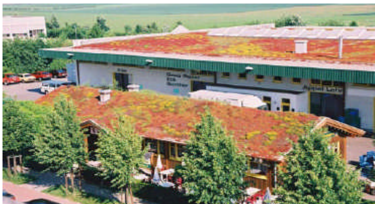
Végétalisation de toits plats et en pente sur cet exemple de bâtiments industriels. Photo extraite du site www.btech.be
