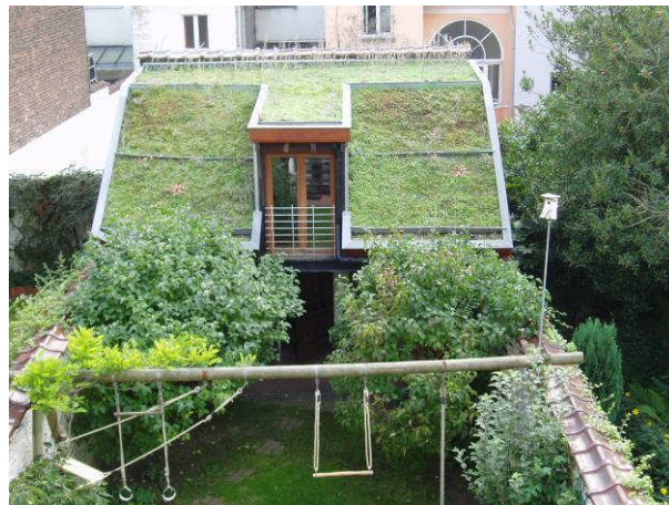
Depuis le 1 er étage, on peut voir que le toit végétalisé comprend une partie plate et des pans en pente. Photo IEB Sabine Vanderlinden
