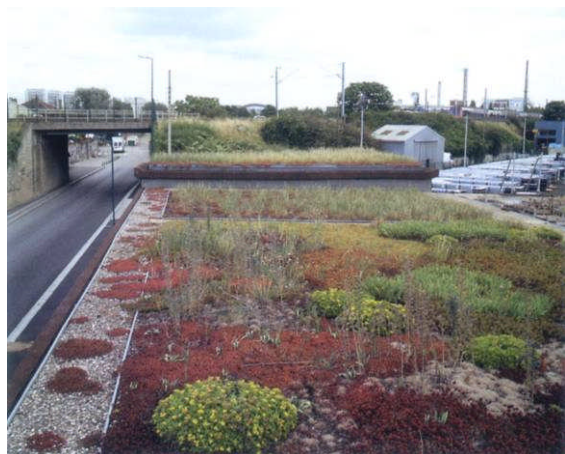
Toiture verte sur un bâtiment le long d'une voirie. La bande de graviers roulés est ici retenue par une fine bordure. Photo extraite du livre « Toits et murs végétaux » Editions du Rouergue. Nigel Dunnett, Noël Kingsbury
