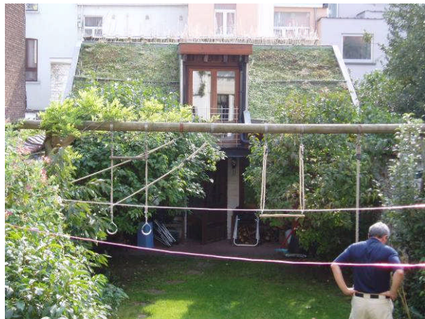
Vue de la toiture verte depuis le jardin. Photo IEB Sabine Vanderlinden
