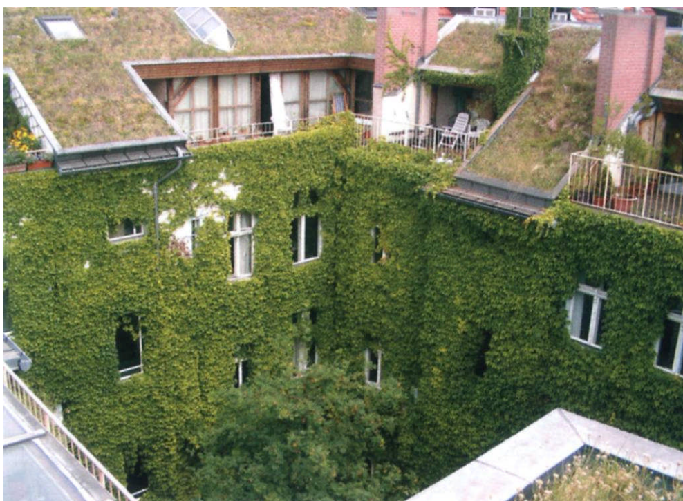
Combinaison de toits et de murs végétalisés, tout bénéfique pour les habitants tant à l'intérieur qu'à l'extérieur des bâtiments. Photo extraite du livre « Toits et murs végétaux » Editions du Rouergue. Nigel Dunnett, Noël Kingsbury
