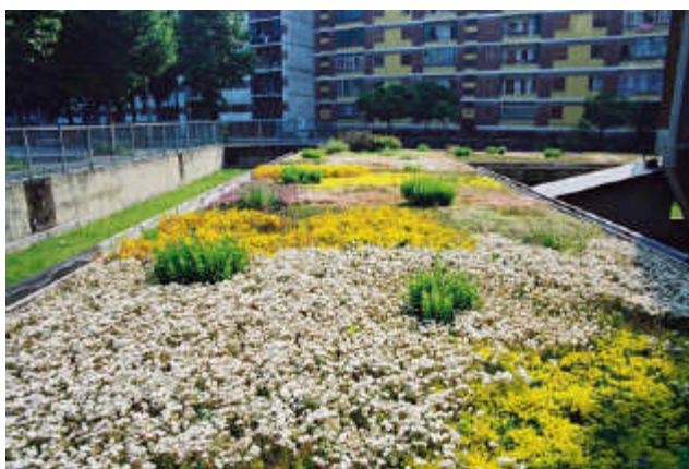
Plantation de type mosaïculture. La vue depuis les appartements s'en trouve fortement améliorée (par rapport à une grande surface noire de l'étanchéité nue). Photo extraite du site www.btech.be
