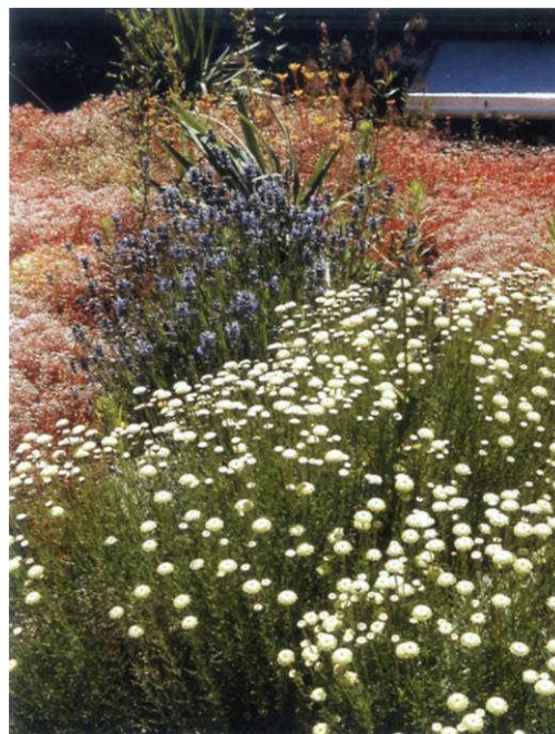
Diversité surprenante sur ce toit vert extensif d'un gymnase parisien.
