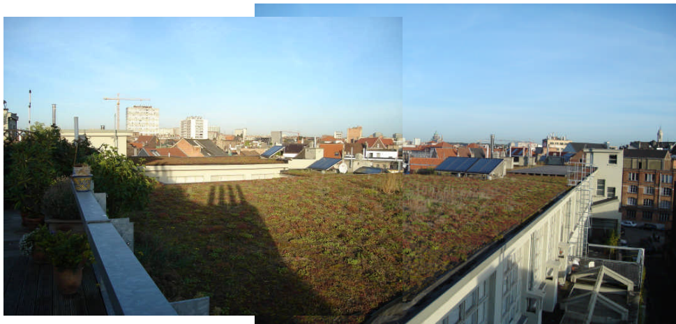
Vue d'ensemble des toits végétalisés depuis une terrasse d'appartement. Photo IEB Sabine Vanderlinden
