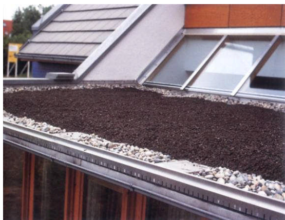
Toit prêt à être planter. Photo extraite du livre « Végétalisation des toitures », Edition Ulmer. Brigitte Kleinod
