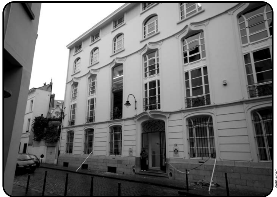
Le 5 décembre, la Ville de Bruxelles a fait interrompre le remplacement de châssis Art Nouveau dans le bâtiment de l'architecte Vizzavona, 23, rue Philippe de Champagne. Raisons : le propriétaire, la Communauté flamande a placé des modèles (légèrement) différents sans demander de permis d'urbanisme.
