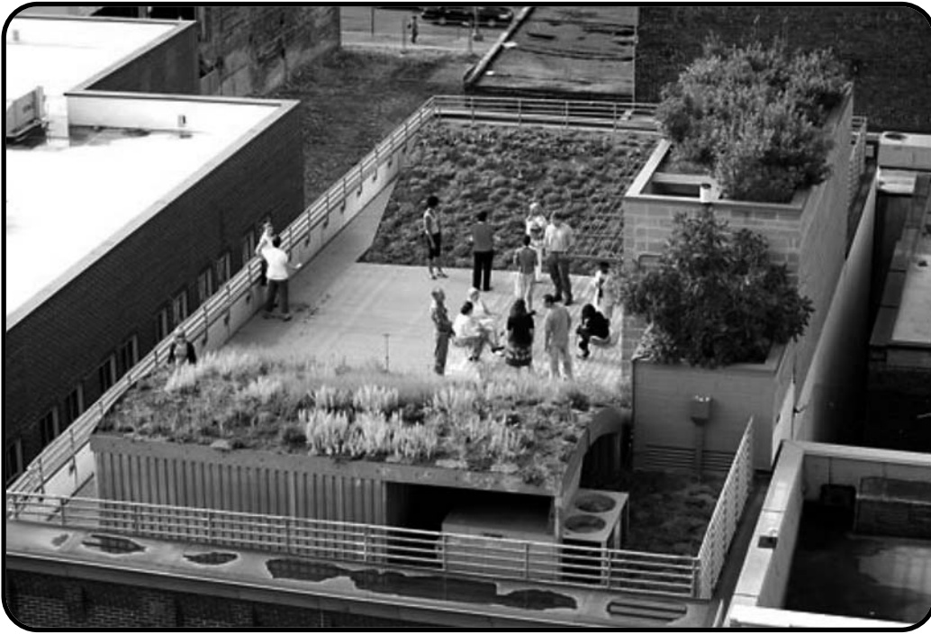
Les toitures vertes, sur les toits plats : un des paramètres qui devraient être intégrés dans tout projet urbanistique, pour la retenue des eaux de pluie et le bénéfice en termes d'isolation thermique.
