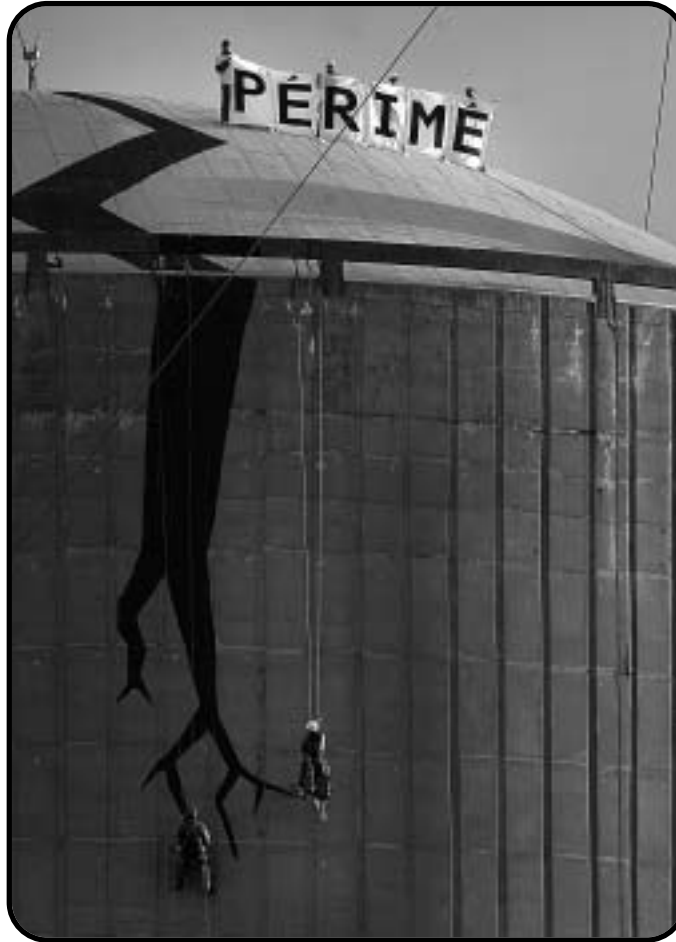
Le 25 octobre 2006, une trentaine de militants de Greenpeace ont investi le site de la centrale nucléaire de Tihange pour dénoncer le vieillissement des réacteurs nucléaires belges et les problèmes de sécurité qui en découlent.
