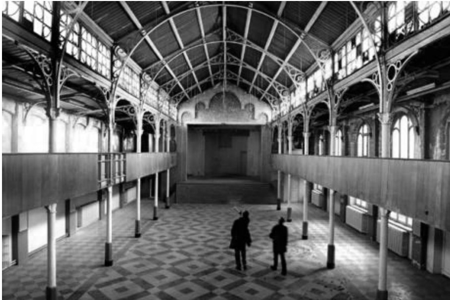
Vue générale de la salle
